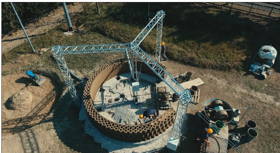
Фиг. 4. Роботът Stone Spray в процеса на изграждане на къщата Гая
