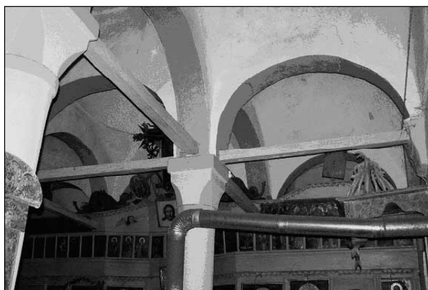
Образ I. Сводестата покривна конструкция на калугеровската църква
